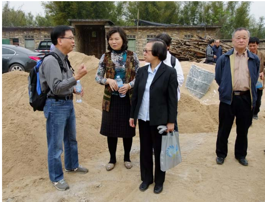
2012 年 3 月 28 日，作者（左二）陪同香港善一堂爱心人士到藤县金鸡镇兴隆小学视察在建教学楼
